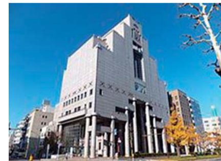
千葉市美術館は昭和2年に建てられた旧川崎銀行千葉支店の建物を保存・修復し、中央区役所との複合施設として設計、平成7年に建築されました。
